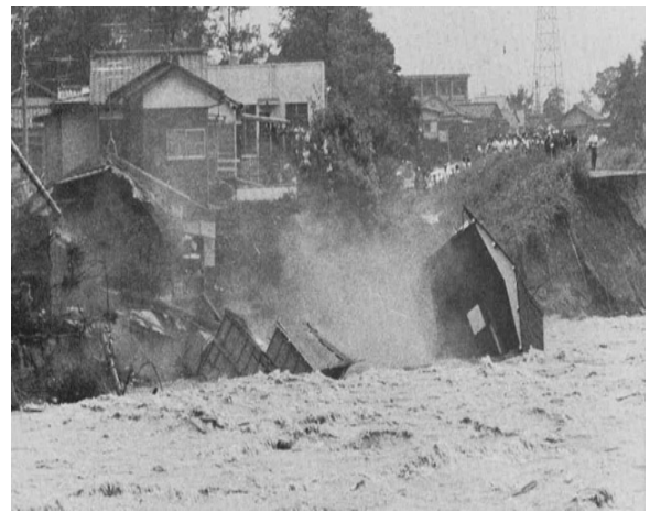
【写真出展：「多摩川堤防決壊記録」（東京都狛江市）】
