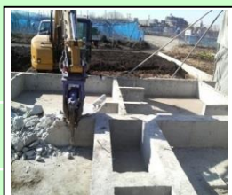
基礎等の解体
