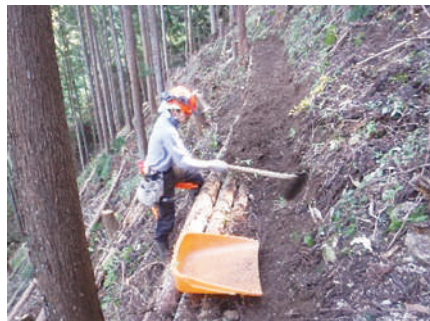
歩道新設の様子(本宿地区)
