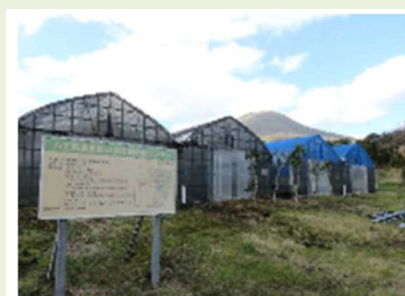
八丈町農業担い手育成 研修センター
