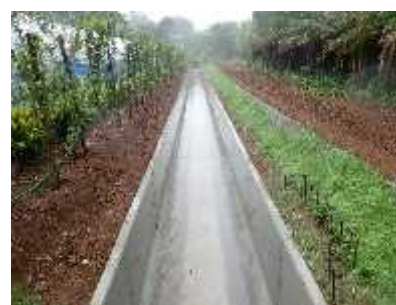
農業用排水路
