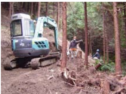
〈森林作業道の開設〉
