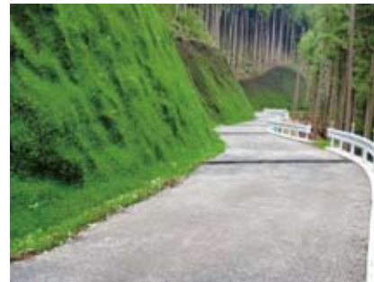
〈壁面が緑化された林道〉
