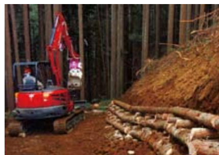
〈丸太組工を用いた森林作業道の作設〉
