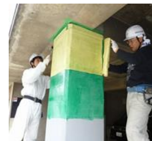
【高強度繊維補強】 陸橋の補強
