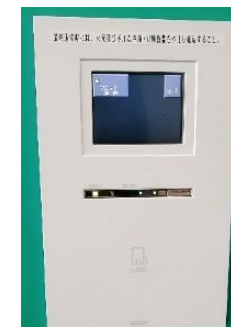
改修後の各室カードリーダー
