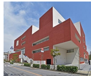
城東職業能力開発センター
