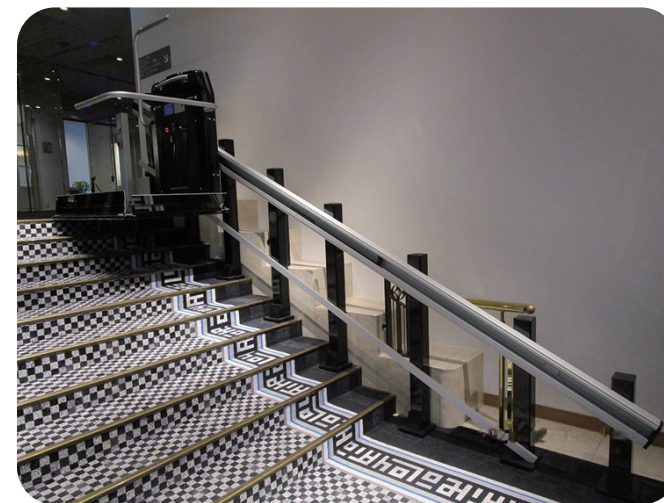
バリアフリー化事例 （階段に車いすリフトを設置）
