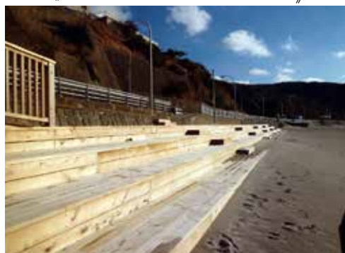
《神津島・前浜海岸デッキ整備》
