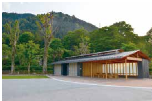
《青梅市・柚木苑地における施設整備》
