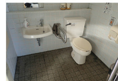
展望避難休憩舎の車いす対応トイレ
